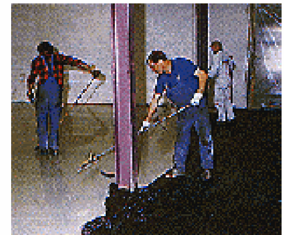
Fedőréteg felhordása a vezetőrétegre
