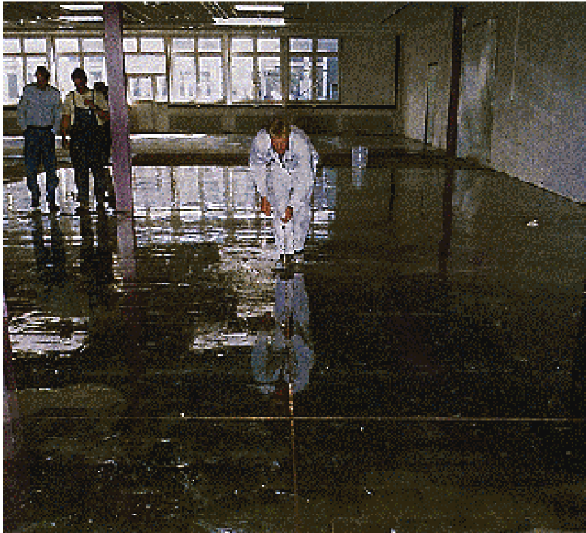
Rézszalag felragasztása az alapozásra
